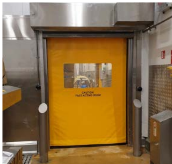
Bis zu 2,0 m/s mit der Standard-Frequenzregelung
