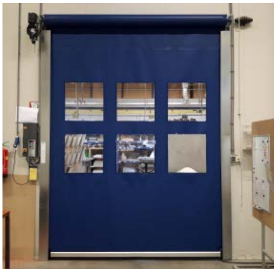
Robust: die HardEdge-Schließkante von Alpha
