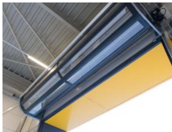
Der Durchgang wird dauerhaft von einem Lichtgitter überwacht
